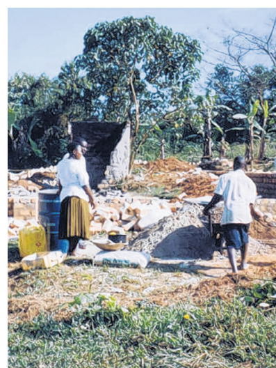
Die Bauarbeiten an der mit Spenden aus Babenhausen finanzierten Schule.
